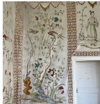
Schloss Oranienbaum, südliches Gesellschaftszimmer, Nordostecke mit starken Deformationen der Leinwand durch Abriss der Bespannung an der oberen Spannleiste
