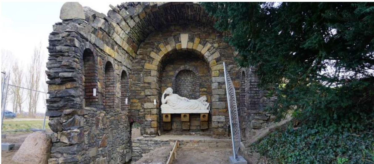
Die Grotte der Egeria im Bauzustand (© Janin Müller)
