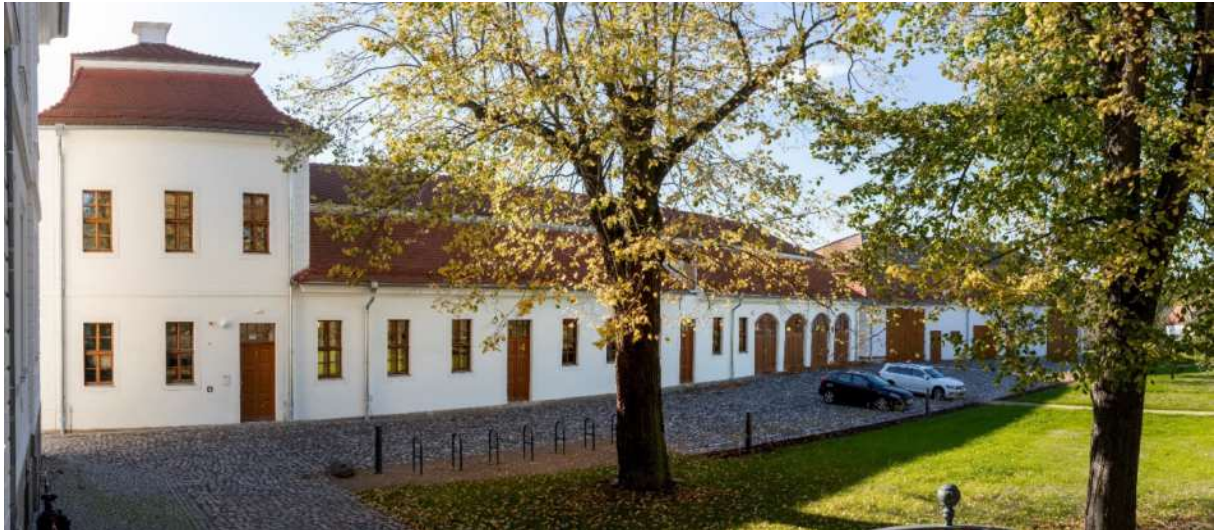
Schlossensemble Großkühnau, Panorama des Geländes mit Remise und Scheune nach abgeschlossener Sanierung (© KsDW, Bildarchiv, Peter Dafinger)
