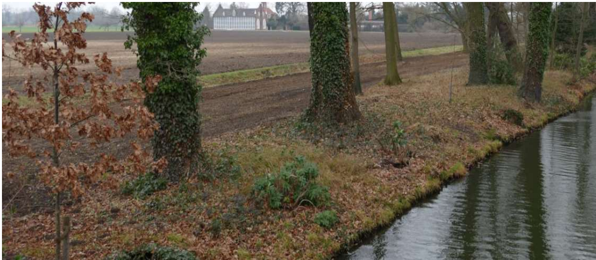
Instandgesetzter Abschnitt am Wolfskanal mit Sicht zum Palmenhaus (© Michael Keller)
