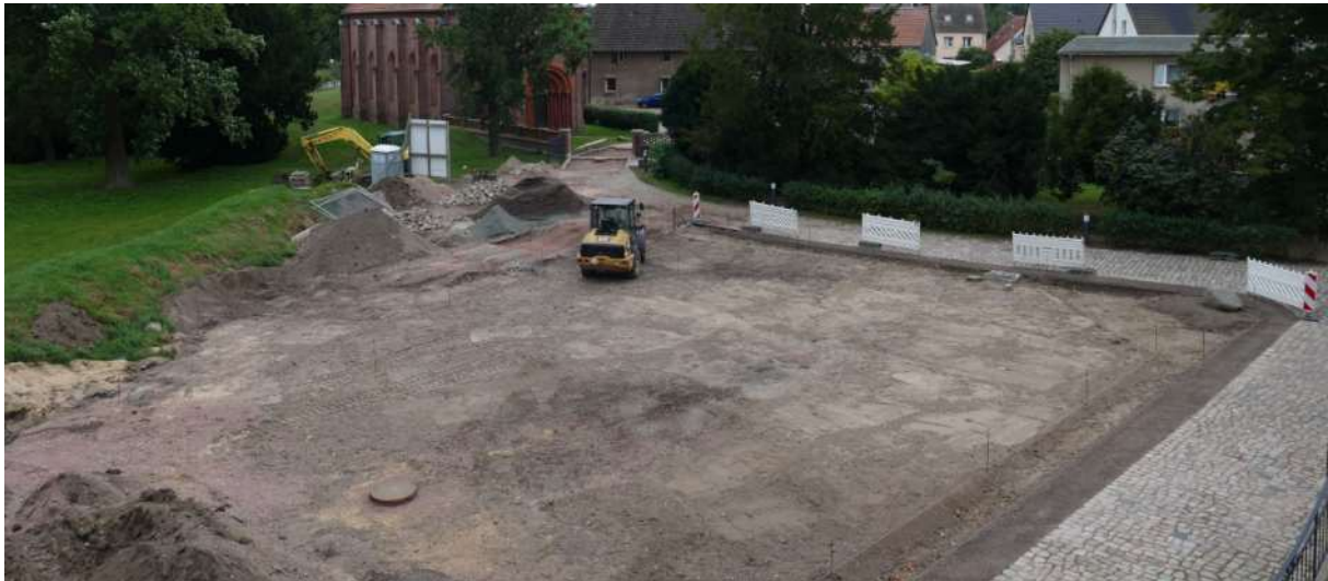
Rückbau der Baustelleneinrichtungsfläche im Bereich des östlichen Schlossgartens Großkühnau (© Michael Keller)
