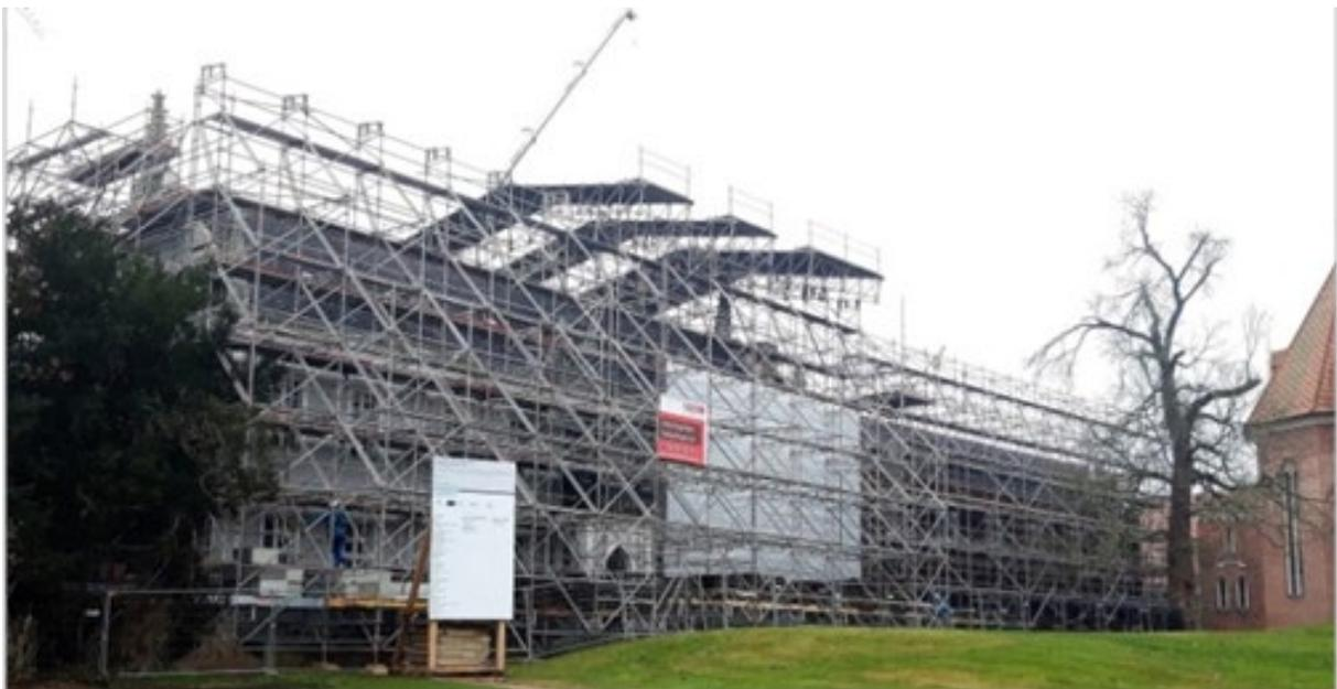
Abb. 1 Wörlitzer Park, eingerüstetes Haus der Fürstin während der Errichtung des Wetterschutzdaches
